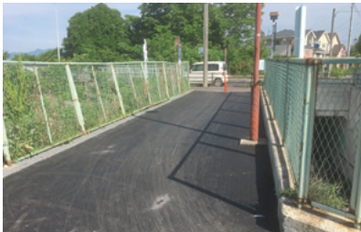
南部大橋東詰め南下歩道を全面舗装 (5月12日撮影)
