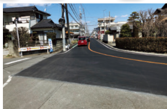
南部大橋線信号南の南北道路の舗装 南町二丁目
