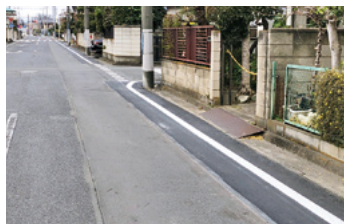
道路路肩の段差解消舗装 南町四丁目
