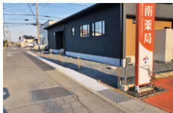
道路側溝新設工事 櫛島町
