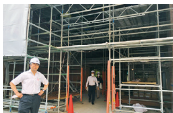
新議会庁舎工事進捗見学/ 5月30日
