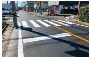
南部大橋線信号南の南北道路の舗装 南町二丁目
