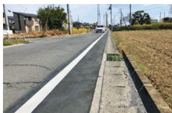
協立病院前道路の路肩歩道段差解消舗装 六供町
