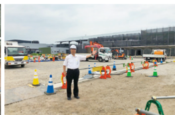
田口町の新設道の駅工事現場見学/ 6月21日
