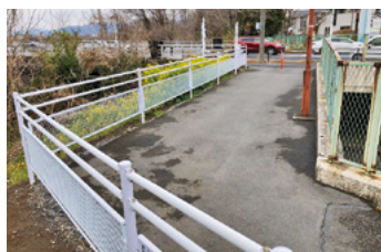
南部大橋東詰め南下歩道フェンス取替工事 南町二丁目
