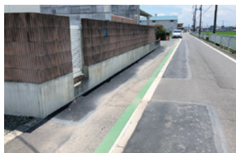
路肩舗装工事／下阿内町
