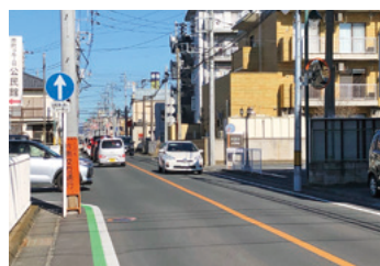
カーブミラー設置／南町二丁目
