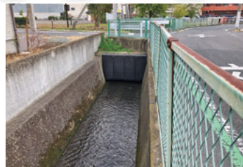
風呂川防音幕の設置／六供町生川
