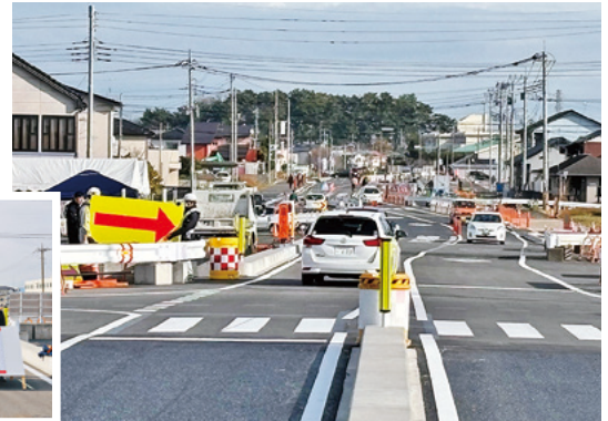
江田天川大島線暫定2車線開通で一般車両が通行
