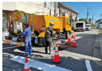
下水道管補修／南町二丁目
