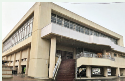
日吉体育館にエアコンが設置されます
