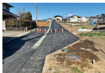
道路拡幅工事始まる／鳥取町
