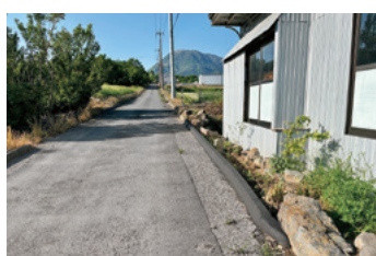
路肩補修工事／東金丸町
