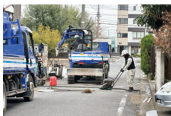
水道補修工事／南町四丁目
