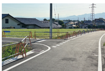
道路の新設工事／鳥取町
