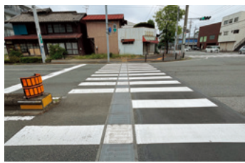
横断歩道の凹凸改修／南町四丁目
