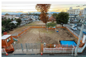
宗甫分公園バリアフリートイレ設置工事／南町二丁目
